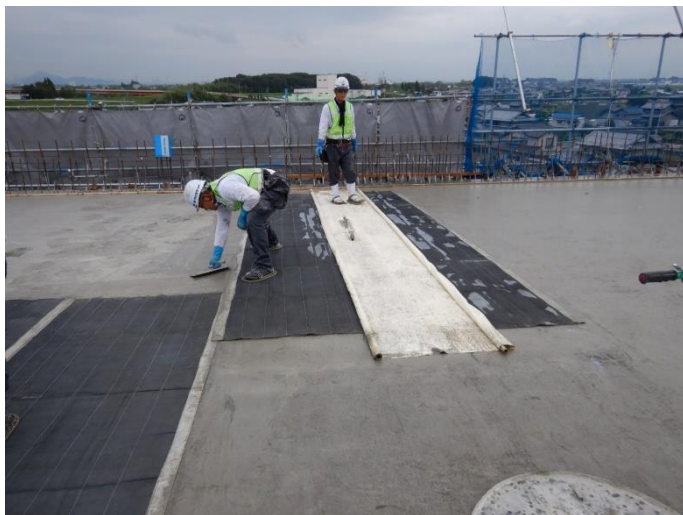
真空マット敷設
