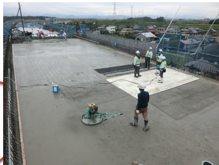
真空脱水圧密工程
